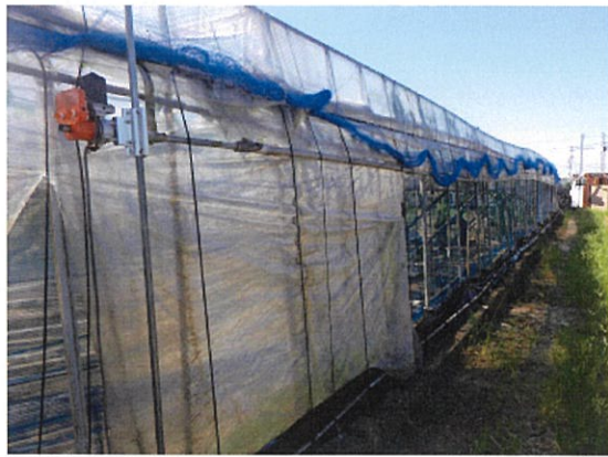
自動換気装置による開閉風景
